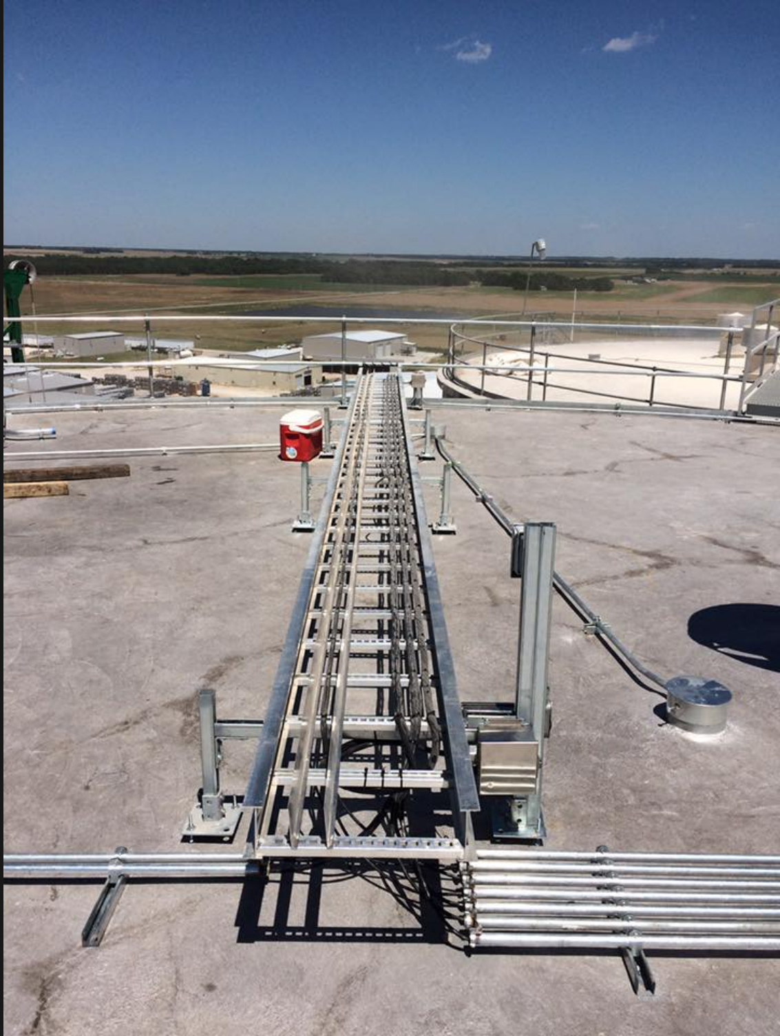
Kansas Ethanol Project in Lyons, KS.
